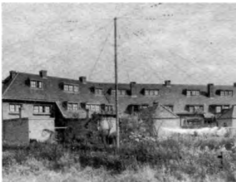
Ein vorbildlicher Antennenmast in der Philips-Gartenstadt Eindhoven.
