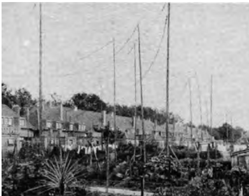
— Und wie es nicht sein sollte: Die Antennen stören sich gegenseitig — und schön ist die Anlage auch nicht.
